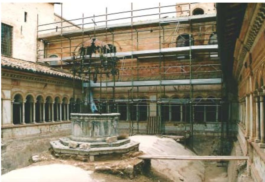
La volta della cisterna, scoperta per la sostituzione del pavimento dell'impluvium, durante il restauro del 2002. A destra si intravede il sistema di filtraggio e arricchimento delle acque piovane, che passavano, attraverso del pietrisco, per un percorso a sifone prima di riversarsi all'interno attraverso aperture situate più in alto rispetto al piano di raccolta.
